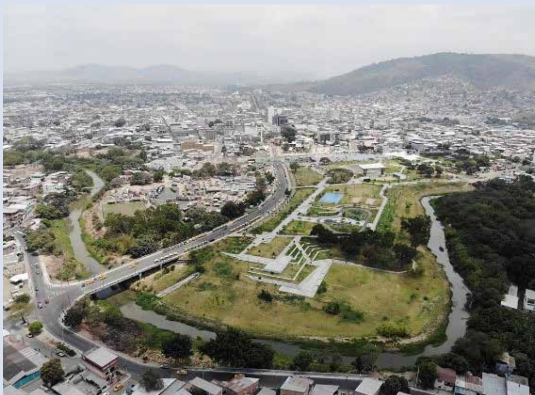
Foto 4. Parque Las Vegas de Portoviejo para control de inundaciones
