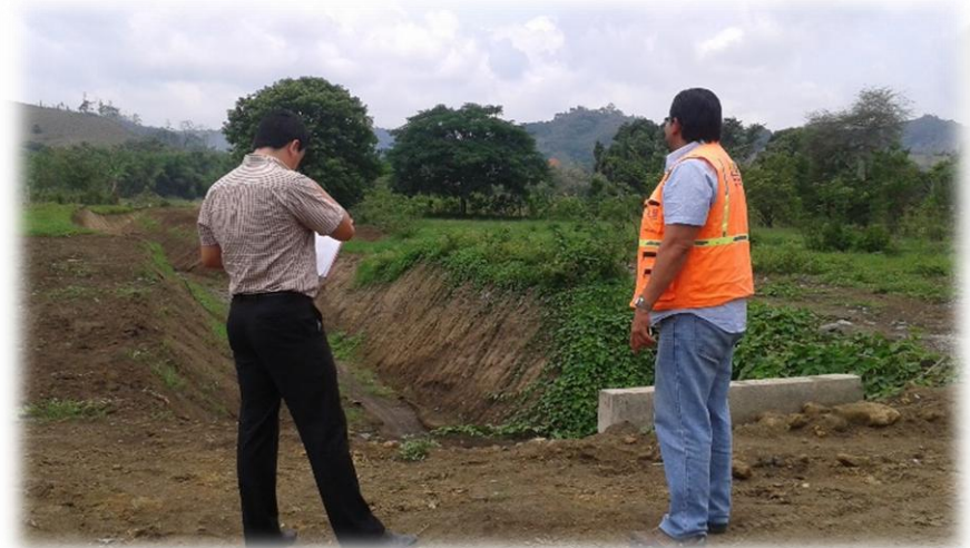
CANAL DE HORMIGÓN ARMADO PARA ENCAUSAR LAS AGUAS DEL ESTERO EL TILLO
