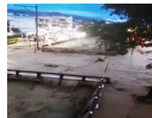
Inundación por desbordamiento del río Malacatos- Loja, 2025
