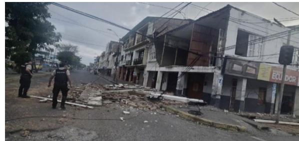
Esmeraldas sufrió el viernes 25 de abril de 2025 daños por un temblor de 6,1 grados.
