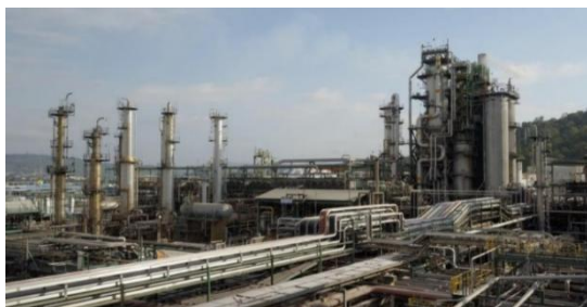
Petroecuador suspendió temporalmente las operaciones del Sistema de Oleoducto Transecuatoriano (SOTE) por el sismo
