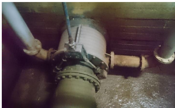
Ilustración 2: Imagen de aducciones de aire operando incorrectamente en el desagüe de fondo del embalse Poza Honda en el Sistema Trasvases Manabí
