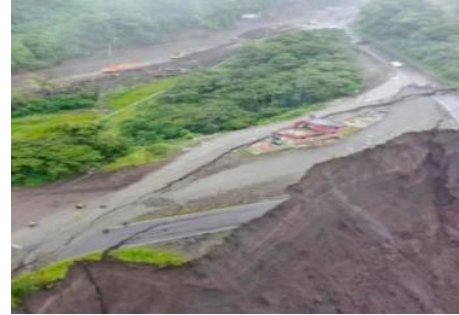
Pérdida de 520 metros de vía en el km 64 - vía E45 y de la vivienda denominada Casa Rosada en San Luis, 18/05/2021
