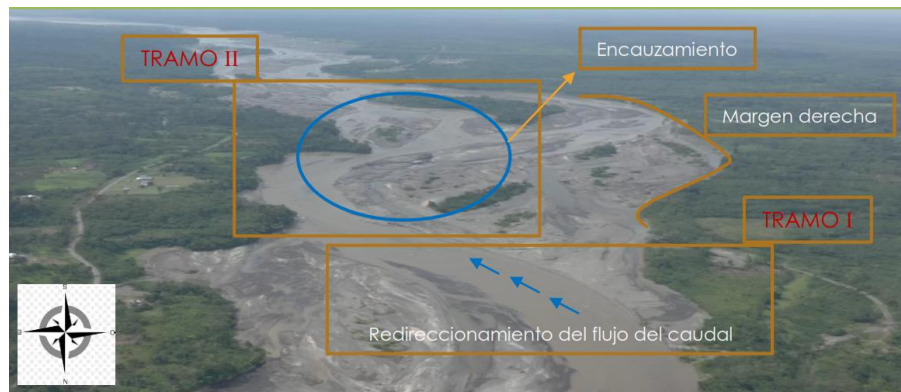
Encauzamiento y redireccionamiento del flujo del caudal, noviembre 2022.
