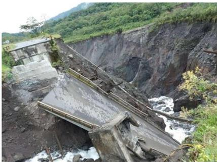
Fotografía 3. Colapso total del puente sobre el río Montana. Fuente: SNGRE C22 UMEVA Napo Orellana
