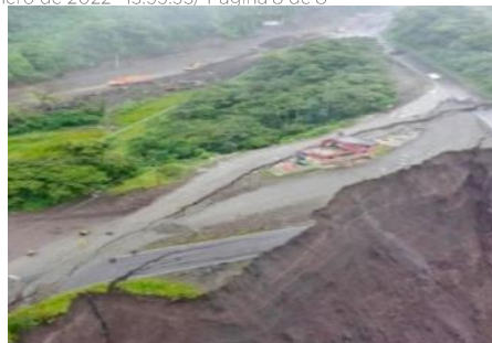
Pérdida de 520 metros de vía en el km 64 - vía E45 y de la vivienda denominada Casa Rosada en San Luis, 18/05/2021
