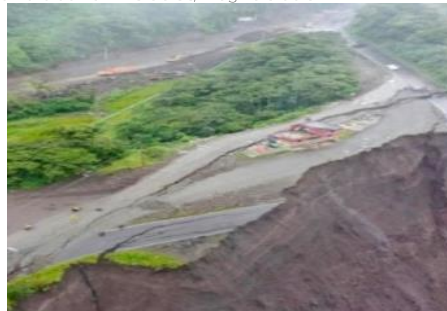
Pérdida de 520 metros de vía en el km 64 - vía E45 y de la vivienda denominada Casa Rosada en San Luis, 18/05/2021
