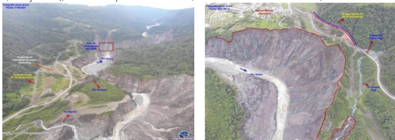
Variantes en construcción. Fuente: PETROECUADOR
