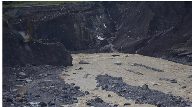
EFFECTOS DE LA EROSION REGRESIVA EN LA ZONA DE LA VENTANA 2 (01/11/2021)
