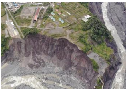
Riesgo por la inestabilidad de los taludes en la zona de la ventana 2 y San Luis, 31/07/2021,
