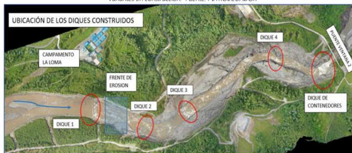
Diques construidos conformados por contenedores. Fuente: CELEC EP
