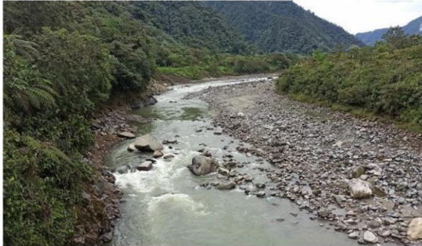
FRENTE DE EROSION ABS. 7+900 AGUAS ARRIBA DEL PUENTE DE SAN CARLOS Y (09/11/2021)
