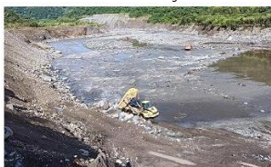
Trabajos para modificar y proteger con enrocado el talud. Fuente: PETROECUADOR
