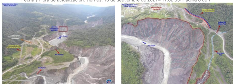
Variantes en construcción. Fuente: PETROECUADOR
