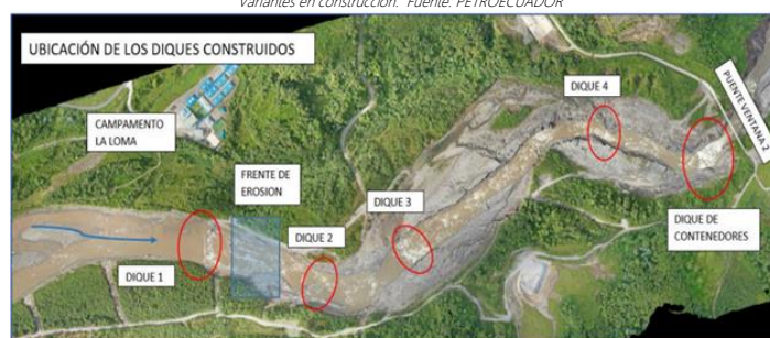
Diques construidos conformados por contenedores. Fuente: CELEC EP
