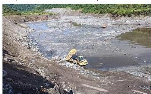
Trabajos para modificar y proteger con enrocado el talud. Fuente: PETROECUADOR
