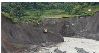
Deslizamientos ponen en riesgo la zona de SINOHYDRO. Fuente: PETROECUADOR
