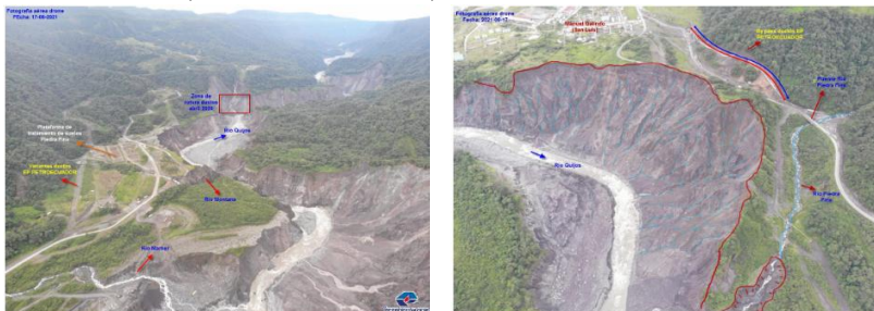
Fotografía 6 y 7: Variantes en construcción. Fuente: PETROECUADOR
