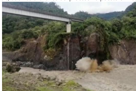
Fotografía 1. Momento en que la base del puente Ventana 2 es socavada por la corriente del río Quijo
