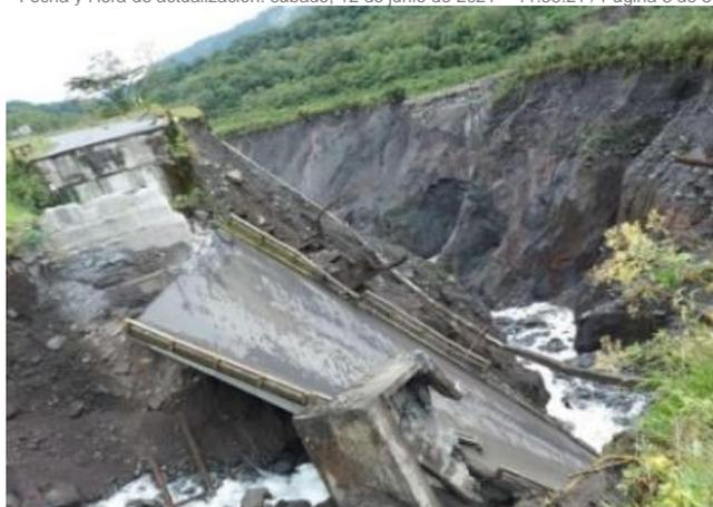
Fotografía 6. Colapso total del puente sobre el río Montana. Fuente: SINGRE CZ2 UMEVA Napo Orellana.
