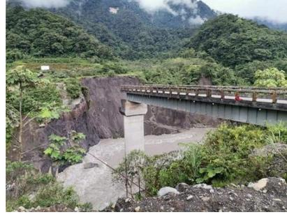
Fotografía 2. Fotografía del puente Ventana 2 ya colapsado
