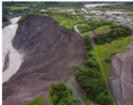
Fotografía 4. Pérdida de la vía de primer orden, sector San Luis.
