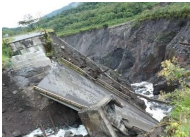
Fotografía 6. Colapso total del puente sobre el río Montana. Fuente: SINGRE C22 UMEVA Napo Orellana.
