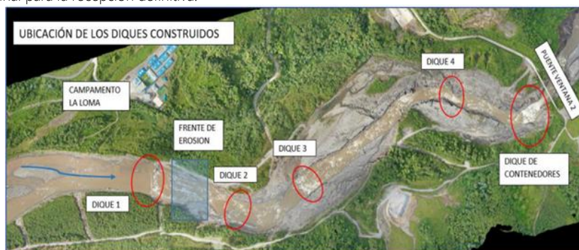
Fotografía 8: Diques construidos conformados por contenedores. Fuente: CELEC EP
