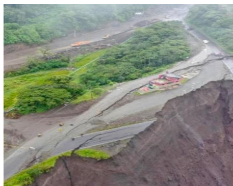
Fotografía 3. Fotografías aéreas de la vía Quito-Lago Agrio, sector El Reventador-San Luis, sitio casa rosada
