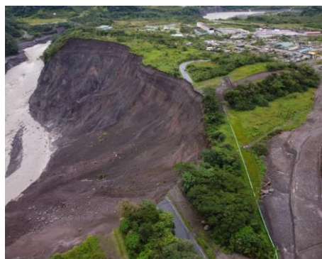
Fotografía 4. Pérdida de la vía de primer orden, sector San Luis.
