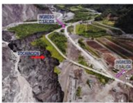
Fotografía 6. Variante provisional de 650 metros en el km. 67.5 habilitada al paso vehicular sin restricciones desde el pasado mes de junio.
