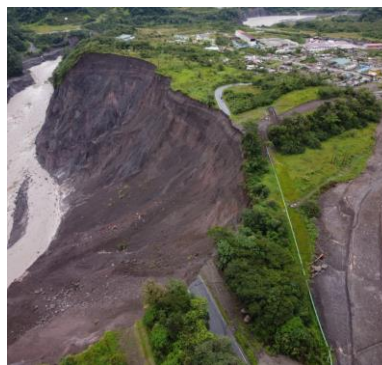
Fotografía 6. Pérdida de la vía de primer orden, sector San Luis.
