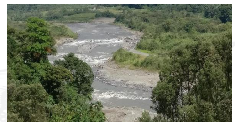
Fotografía 1. Vista panorámica del frente de erosión y dique después de la crecida del 19/04/20
