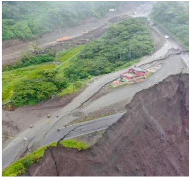
Fotografía 3. Fotografías aéreas de la vía Quito-Lago Agrio, sector El Reventador-San Luis, sitio casa rosada.
