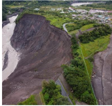
Fotografía 4. Pérdida de la vía de primer orden, sector San Luis.
