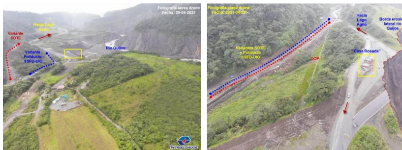
Fotografías 5 y 6. Ubicación de trazados de ductos. Fuente: EP Petroecuador.
