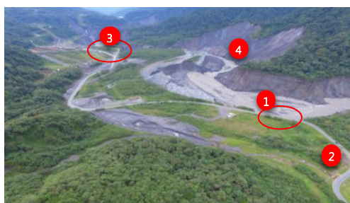
Fotografía 1. Afectaciones en los diferentes tramos de la erosión del río. Fuente: MTT3
