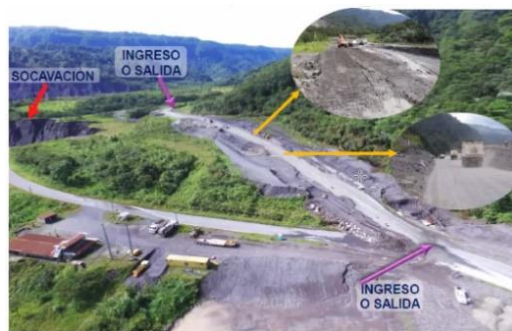
Fotografía 6. Construcción de la variante provisional No. 02
