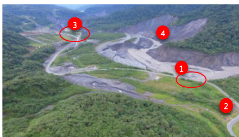
Fotografía 2. Afectaciones en los diferentes tramos de la erosión del río. Fuente: MIT3
