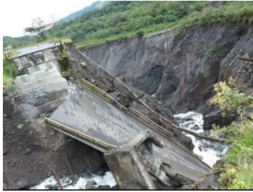
Fotografía 4. Colapso total del puente sobre el río Montana. Fuente: SNGRE C22 UMEVA Napo Orellana
