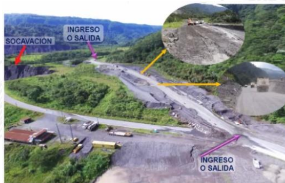
Fotografía 6. Construcción de la variante provisional No. 02
