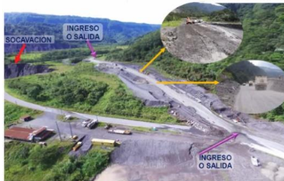
Fotografía 6. Construcción de la variante provisional No. 02
