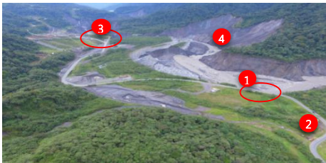
Fotografía 2. Afectaciones en los diferentes tramos de la erosión del río. Fuente: MTT3
