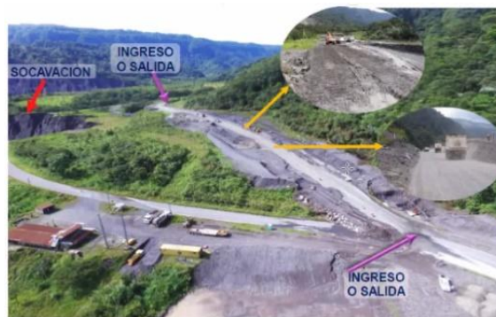
Fotografía 6. Construcción de la variante provisional No. 02
