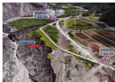
Fotografía 5. Variante provisional de 650 metros en el km. 67.5 habilitada al paso vehicular sin restricciones desde el pasado mes de junio.
