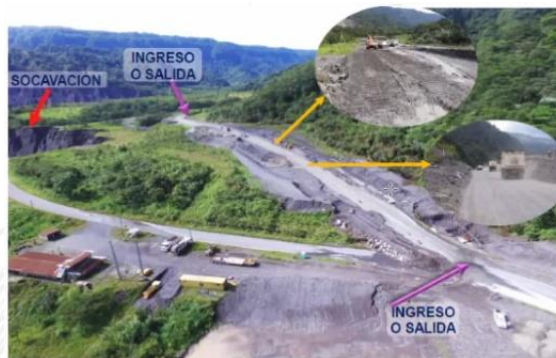
Fotografía 6. Construcción de la variante provisional No. 02
