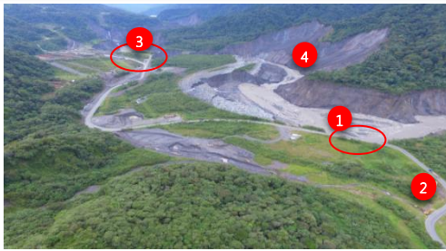
Fotografía 2. Afectaciones en los diferentes tramos de la erosión del río. Fuente: MTT3
