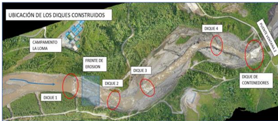
Mapa 4: Diques construidos conformados por contenedores. Fuente: CELEC EP
