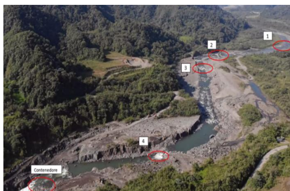
Fotografía 8. Diques construidos conformados por contenedores. Fuente: CELEC EP
