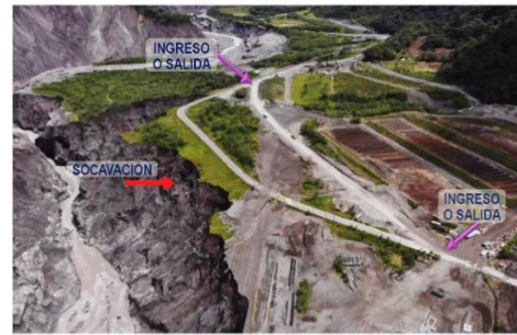
Fotografía 4. Variante provisional de 650 metros en el km. 67,5 habilitada al paso vehicular sin restricciones desde el pasado mes de junio.
