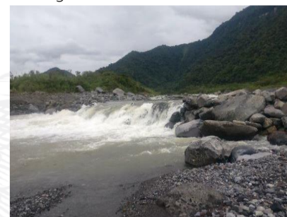
Fotografía 7. Construcción de diques de enrocado de gran tamaño. Fuente: CELEC EP
