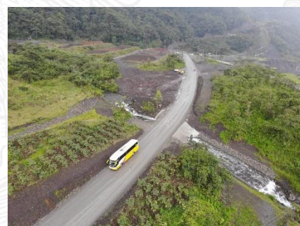
Fotografía 4. Variante provisional de 650 metros en el km. 67.5 habilitada al paso vehicular sin restricciones desde el pasado mes de junio.
