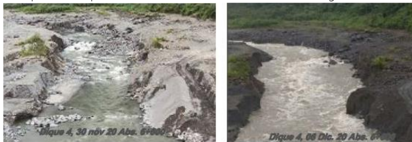
Fotografía 1. Frente de erosión. Fuente: CELEC EP, fecha 6 de diciembre de 2020
