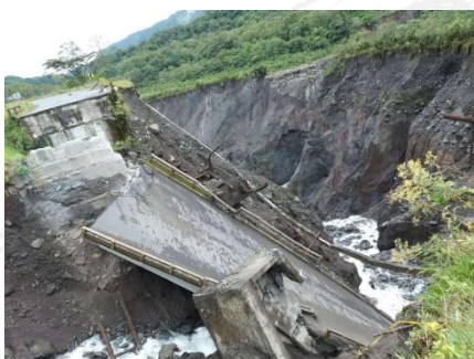
Fotografía 3. Colapso total del puente sobre el río Montana. Fuente: SNGRE CZZ UMEVA Napo Orellana
