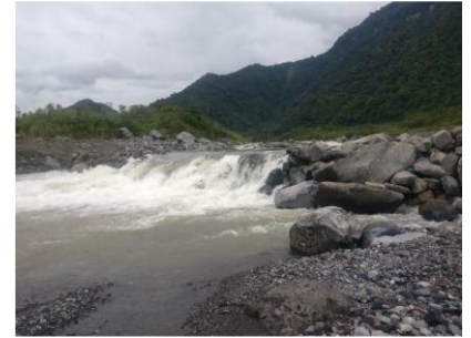
Fotografía 7. Construcción de diques de enrocado de gran tamaño. Fuente: CELEC EP
