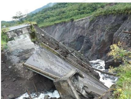
Fotografía 3. Colapso total del puente sobre el río Montana. Fuente: SNGRE CZ2 UMEVA Napo Orellana
