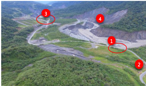
Fotografía 2. Situación vial a causa de la erosión del río – vía Y de Baeza – Lago Agrio. Fuente: MTT3
