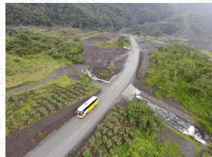
Fotografía 4. Variante provisional de 650 metros en el km. 67.5 habilitada al paso vehicular sin restricciones desde el pasado mes de junio.
