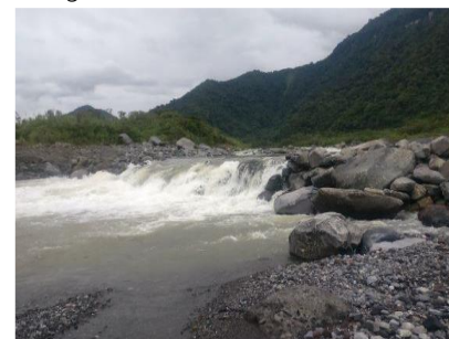
Fotografía 5. Construcción de diques de enrocado de gran tamaño. Fuente: CELEC EP
