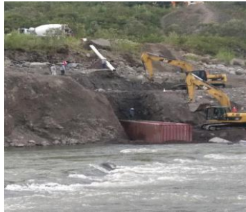
Fotografía 4. Trabajos de reforzamiento de contenedores y construcción de acceso al río. Fuente: CELEC EP
