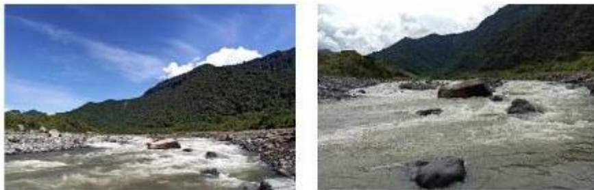
Fotografía 1. Frente de erosión, altura campamento La Loma. Fuente: PETROECUADOR EP., fecha 27 de septiembre de 2020
