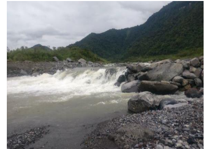
Fotografía 5. Construcción de diques de enrocado de gran tamaño. Fuente: CELEC EP
