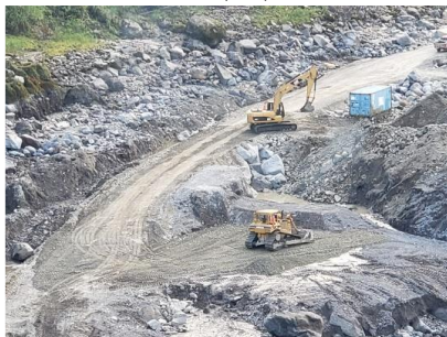
Fotografía 3. Construcción de dique conformado por contenedores. Fuente: CELEC EP
