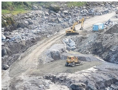
Fotografía 3. Construcción de dique conformado por contenedores. Fuente: CELEC EP
