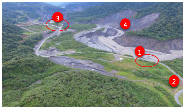
Fotografía 2. Situación vial a causa de la erosión del río – vía Y de Baeza – Lago Agrio. Fuente: MTT3
