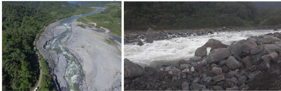
Fotografía 1. Frente de erosión. Fuente: CELEC EP., fecha 28 de agosto de 2020
