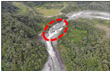
Fotografía 3. Imagen del avance de la erosión regresiva.
