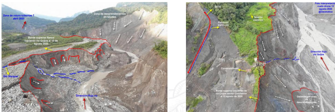
Fotografía 2 y 3. Trazados de ductos captados con drones e inspecciones físicas.
