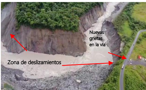
Fotografía 1. Referencia de nuevas grietas en la vía, fuente: Petroecuador
