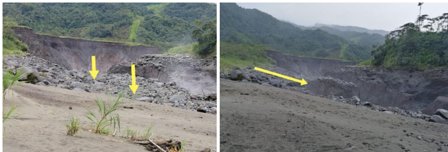
Fotografía 4 y 5. Avance de la erosión en el margen izquierdo del río Coca. Fotos del 21/06/2020 y 22/06/2020, respectivamente
