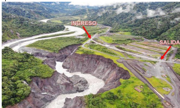
Fotografía 6. Foto aérea de la variante vial con una longitud aproximada de 650 metros
