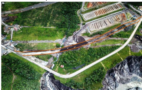
Fotografía 5. Foto aérea de la variante vial con una longitud aproximada de 650 metros
