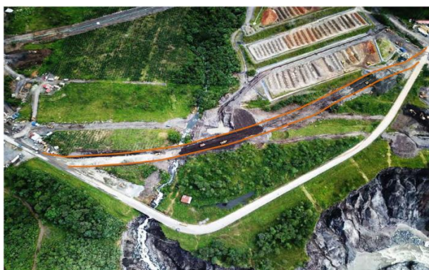
Fotografía 4. Foto aérea de la variante vial con una longitud aproximada de 650 metros.
