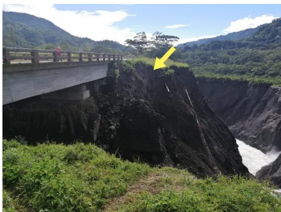
Fotografía 1. Margen izquierdo del río Montana se aprecia un nuevo desprendimiento de material poco consolidado
