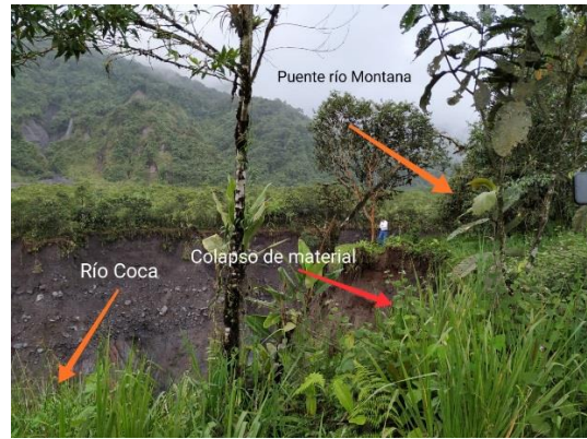
Fotografía 2. Debido al colapso de los taludes de margen izquierdo del río Coca es necesario colocar cintas de peligro para alertar a la comunidad sobre los sectores que presentan alto riesgo para que tengan el cuidado respectivo
