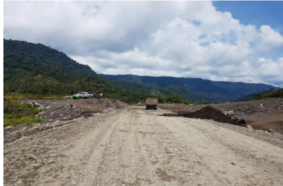
Fotografía 2. Tendido del material de mejoramiento sobre la subrasante.
