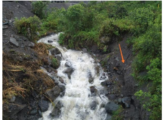
Fotografía 4. Cauze del río Montaña aguas arriba del puente. Presenta material fácilmente erosionable, compuesto por bloques centimétricos soportados en una matriz arenosa.
