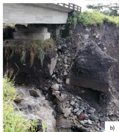
Fotografía 1. a) Erosión del río Montana al 05 de junio de 2020. b) Erosión del río Montana al 11 de junio de 2020
