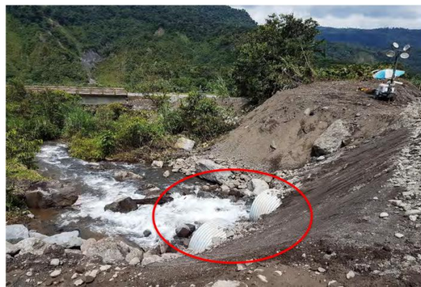
Fotografía 3. Funcionamiento de las 2 alcantarillas de diámetro 1.80 metros, aguas abajo del río Montana.
