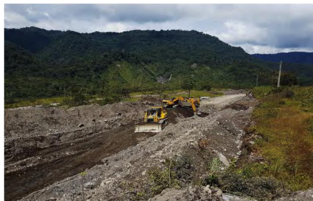
Fotografía 4. Trabajos de nivelación de la subrasante en la variante vial.
