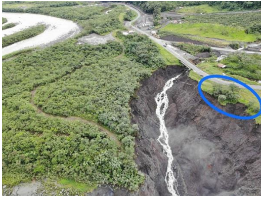
Fotografía 3. Vista panorámica de la ubicación del sector en el cual es necesario colocar cintas de peligro
