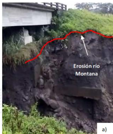
Fotografía 1. a) Erosión del río Montana al 05 de junio de 2020. b) Erosión del río Montana al 11 de junio de 2020
