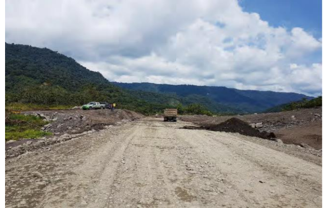
Fotografía 2. Tendido del material de mejoramiento sobre la subrasante.
