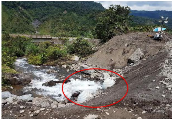
Fotografía 3. Funcionamiento de las 2 alcantarillas de diámetro 1.80 metros, aguas abajo del río Montana.
