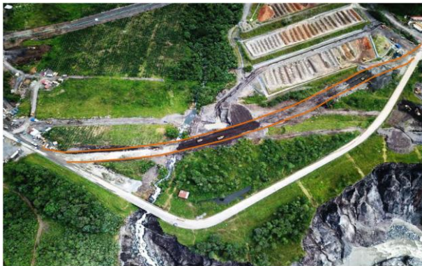
Fotografía 4. Foto aérea de la variante vial con una longitud aproximada de 650 metros.
