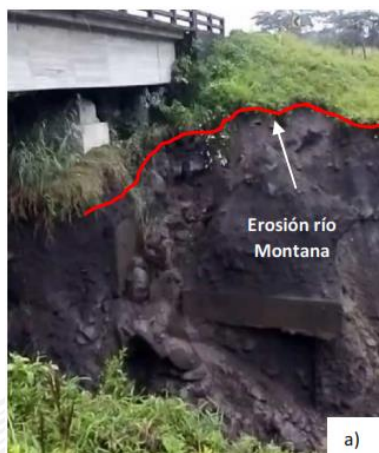
Fotografía 1. a) Erosión del río Montana al 05 de junio de 2020. b) Erosión del río Montana al 11 de junio de 2020
