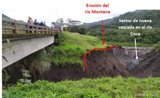
Fotografía 3 y 4. Estado actual de la erosión del río Montana y del puente en la Autopista E45. Fuente: IIGE
