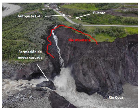
Fotografía 2. Estado de la erosión en el río Montana al 02 de junio de 2020. Fuente: IIGE
