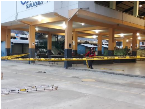
Centro comercial de Gualaquiza por afectaciones
