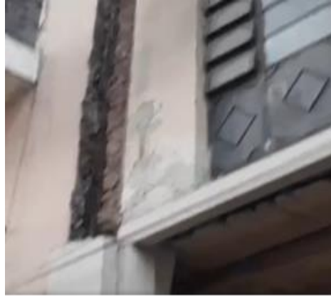
Daños en fachada externa en la calle Sucre y Machala, centro de Guayaquil
