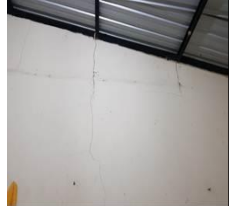
El Oro, fisuras al UPC de la Peaña
