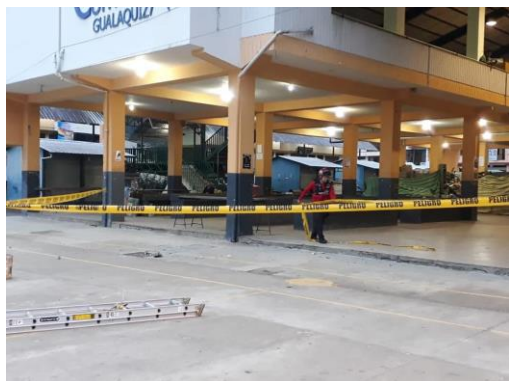
Centro comercial de Gualaquiza por afectaciones
